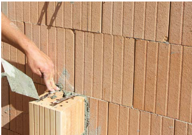
3. Monter le mur intérieur et le raccorder
