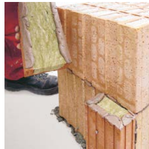
1re couche, demi-brique non coupée dans la zone de l'embrasure de fenêtre
