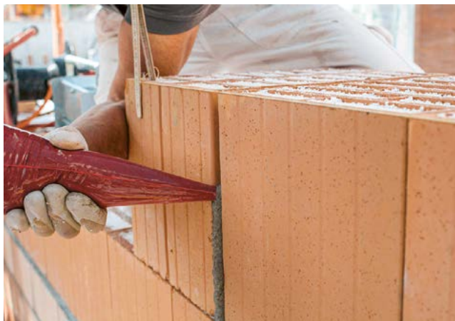
13. Comblers les petits vides entre 5mm et 15mm avec du mortier léger
