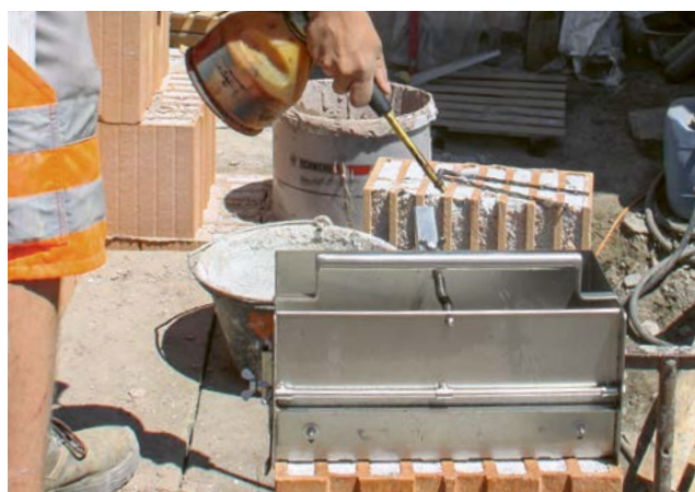
4. Préparer la luge à mortier avec de l'huile de décoffrage
