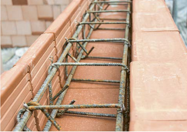
7. Poser la cage d'armature dans la coque U/WU
