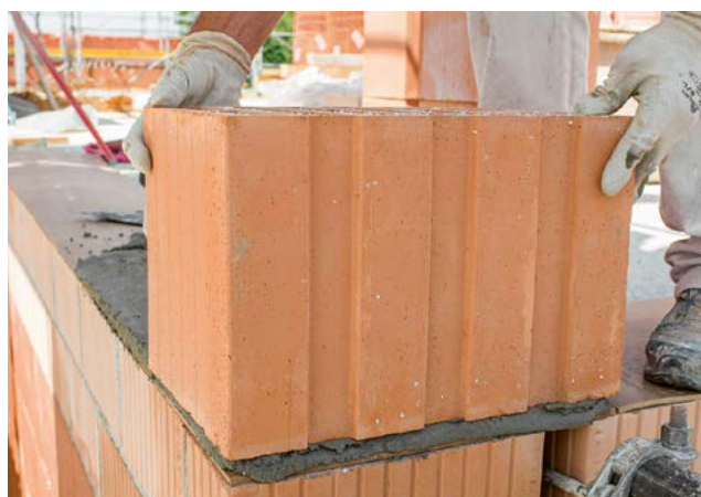
4. Placer la première brique dans l'angle
