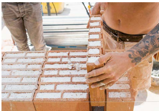
12. Insérer la pièce d'ajustement
