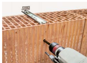
Prépercer un trou à env. 8 cm sous le bord
