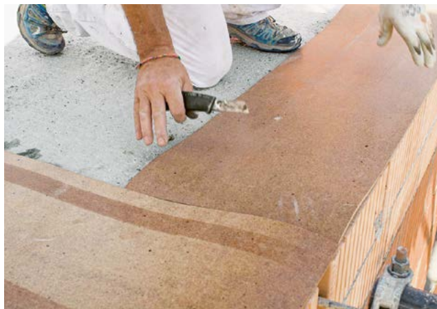
2. Dérouler la couche de séparation ou l'appui
