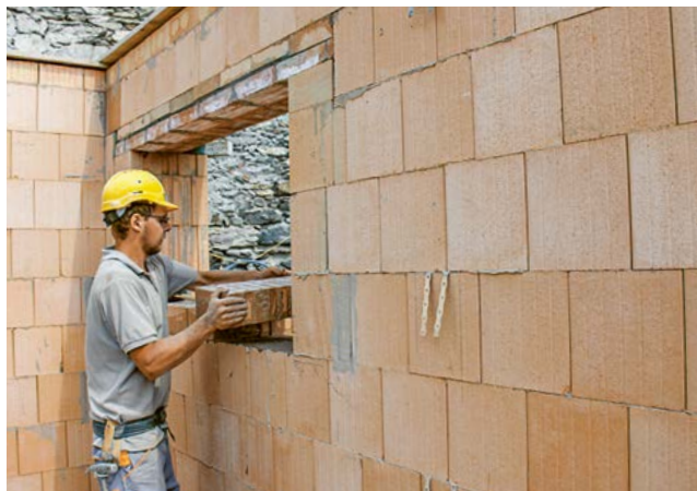
4. Égaliser l'appui entre les embrasures à partir de la dernière couche normale
