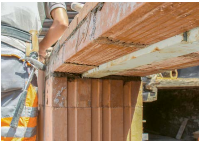
3. Séparer thermiquement les solutions de linteau
