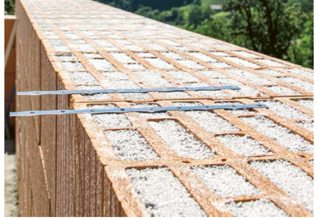
2. Positionner les bandes d'ancrage
