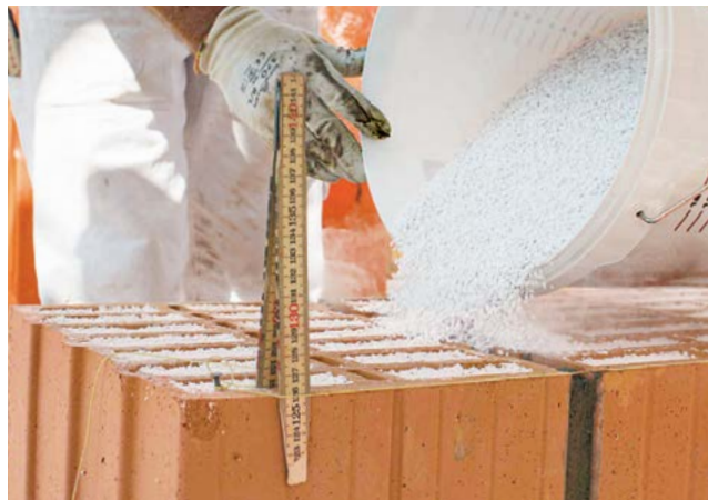
14. Remplir généreusement le vide par le haut avec de la perlite
