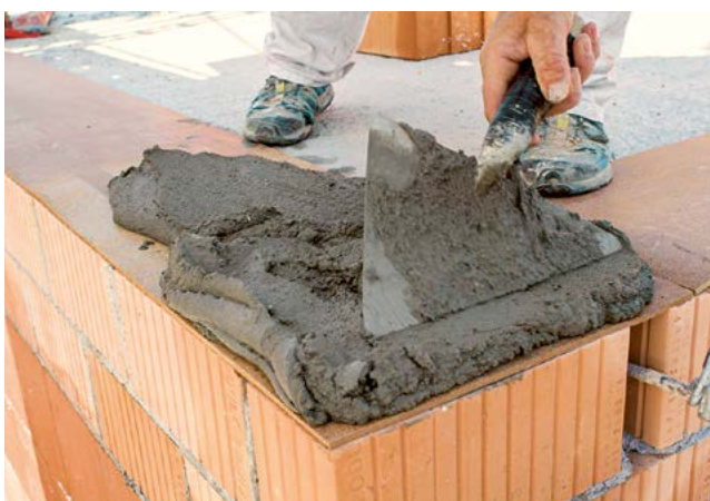
3. Appliquer le mortier de pose pour égalisation
