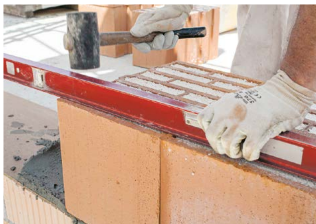
6. Commencer la première couche « mouillé sur mouillé » ou après séchage avec le mortier en couche mince
