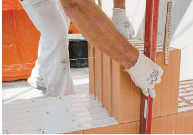
8. Tendre le cordeau et vérifier l'alignement
