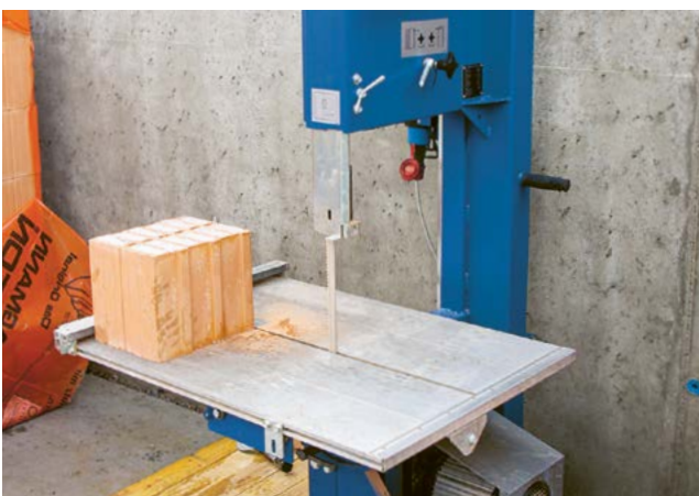
11. Couper la pièce d'ajustement à la scie à ruban
