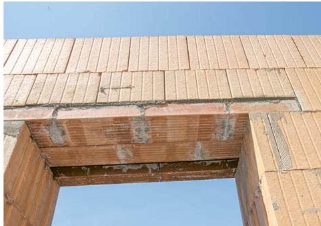
2. Remplir les joints verticaux de mortier en couche mince (trempé)
