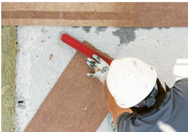
3. Couper l'appui de mur Porotherm Pronouvo
