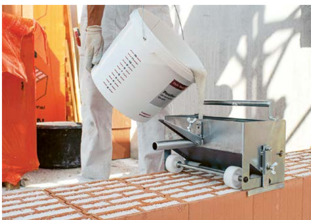
5. Remplir la luge à mortier
