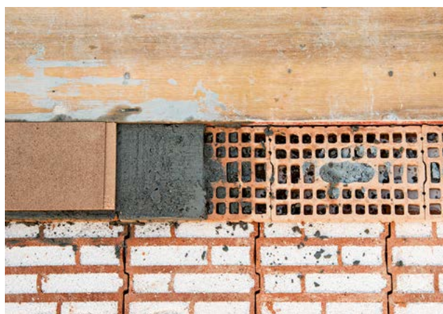
2. Les appuis de déformation sont posés sur le lit de mortier
