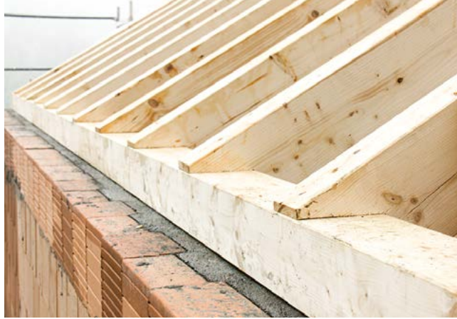
8. Bétonner et, p.ex., fixer la sablière
