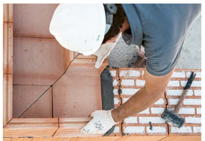
6. Maçonner des coques U-/WU
