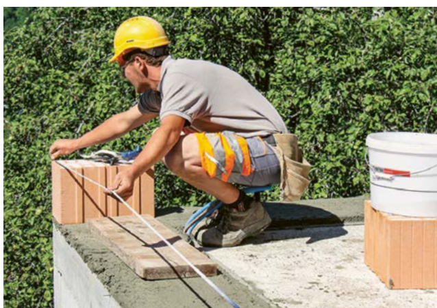
5. Tendre le cordeau sur l'angle
