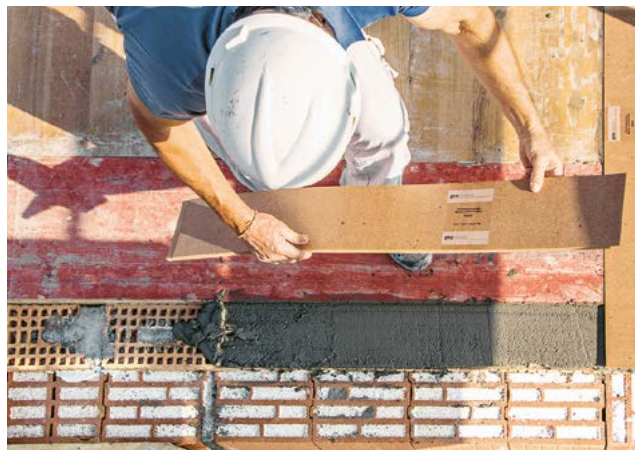
1. L'appui de déformation excentrique, avec bande latérale tendre sur une face et noyau porteur est ajusté
