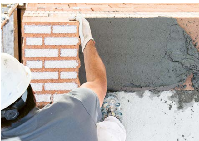
5. Monter le nouveau mur d'étage
