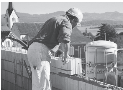
Mehrfamilienhaus-Überbauung in Altendorf SZ
