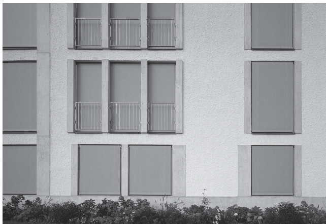
Ein Tragwerk, das man sieht und nicht kaschieren muss, realisiert mit wärmedämmenden Einsteinauerwerk, Mehrfamilienhaus in Zürich
