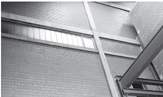
Industriehalle in Rapperswil-Bern, Sichtmauerwerk I + L gerollt besandet.
