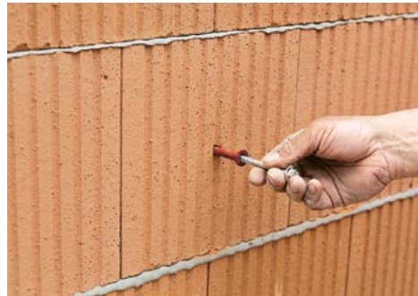
2. Dübel (ggf. mit Schraube) ansetzen
