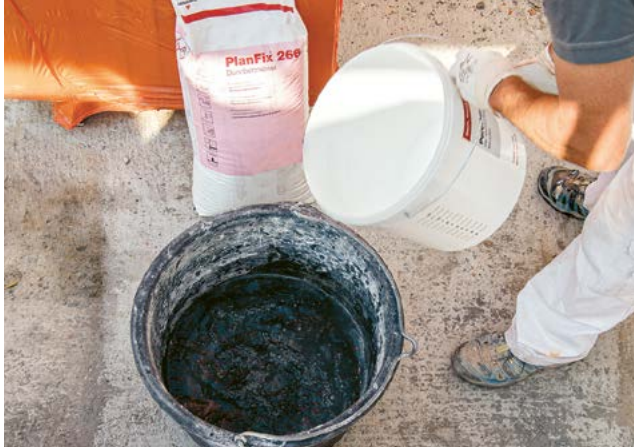
1. Wasser für Mörtelmischung genau abmessen
