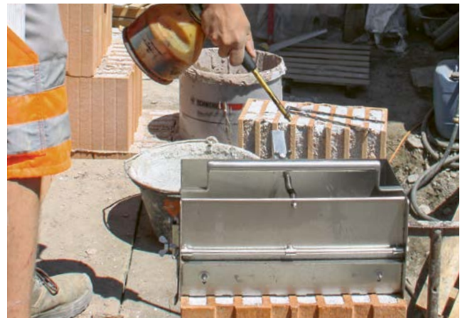
4. Mörtelschlitten mit Schalöl vorbereiten
