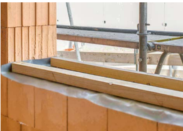
5. Brüstung während der Bauphase vor Witterung schützen
