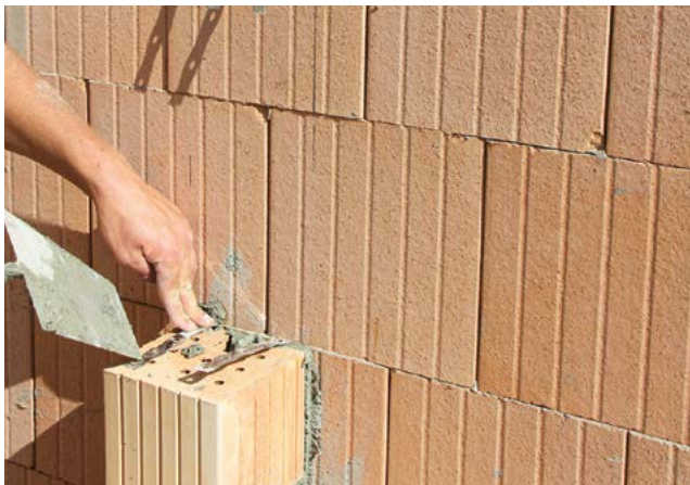
3. Innenwand hochziehen und einbinden
