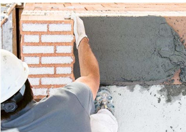
5. Neue Geschosswand hochziehen
