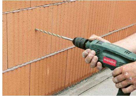
1. Drehbohren ohne Schlag- und Hammerwerk mit scharf angeschliffenem Hartmetallbohrer
