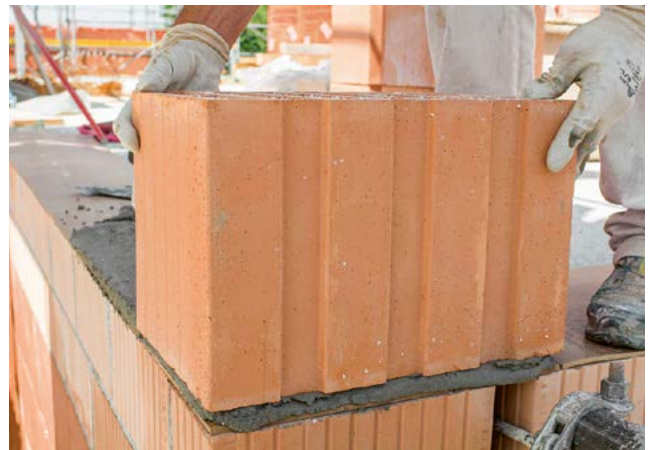
4. Den ersten Stein in der Ecke setzen
