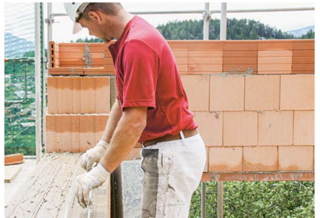
4. Lagerfugenbewehrung in Dünnbettmörtel verlegen
