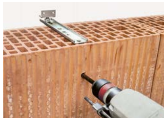
Loch vorbohren ca. 8 cm unter Kante
