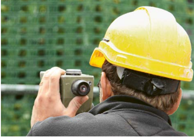
1. Höchsten Punkt der Decke eruieren
