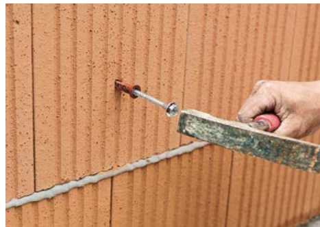
3. Dübel mit Hammer bündig einschlagen
