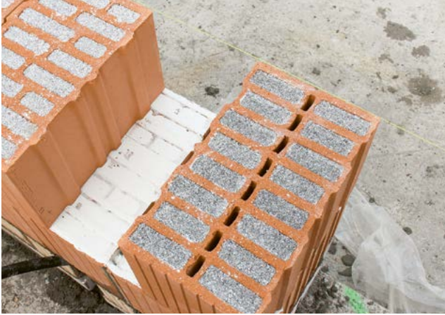
1. An Fenster- und Türleibungen Halbsteine setzen
