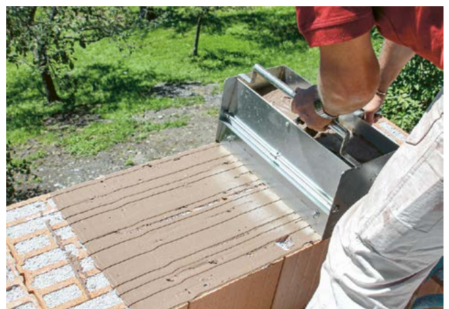
6. Schlitten gleichmässig ziehen und Mörtel auftragen
