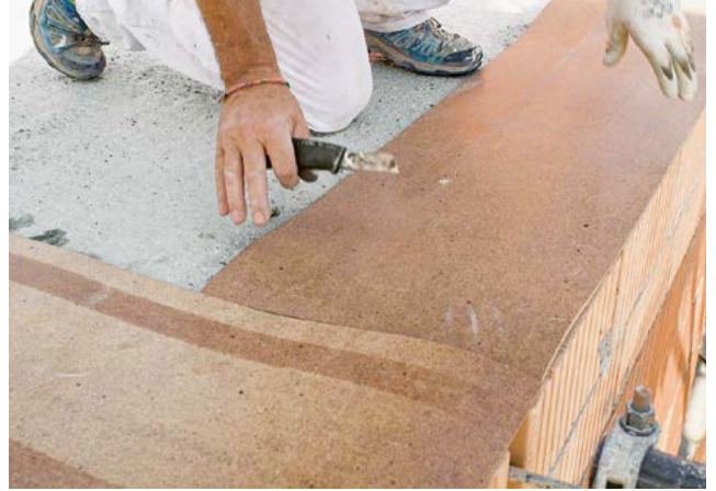
2. Trennschicht bzw. Lager ausrollen
