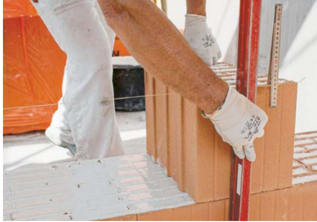
8. Richtschnur ziehen und Ausrichtung prüfen
