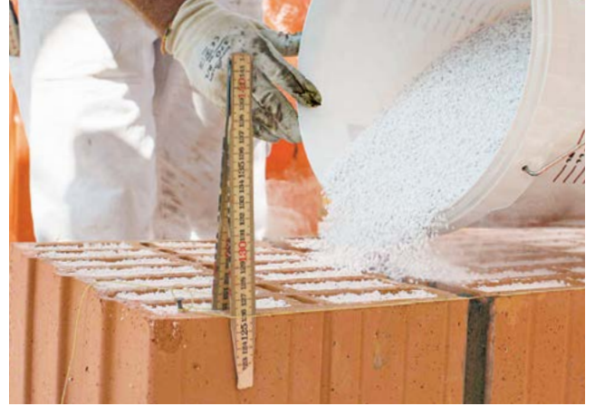
14. Lücke von oben grosszügig mit Perlit auffüllen
