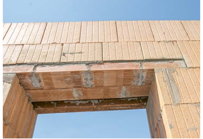
2. Stossfugen bei Sturzübermauerung mit Dünnbettmörtel füllen (tauchen)
