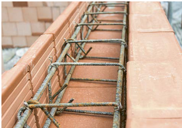
7. Bewehrungskorb in U-/WU-Schale einlegen
