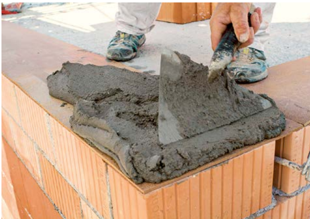
3. Ansetzmörtel zum Ausgleich auftragen
