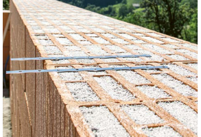
2. Mauerverbinder positionieren
