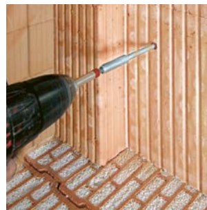
3. Stein im Drehgang bohren
