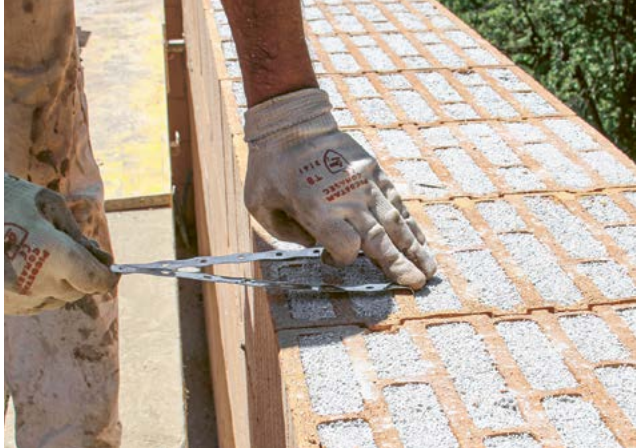
1. Mauerkrone mit Feile ca. 0,5 mm ausnehmen
