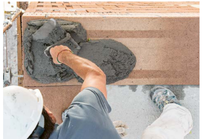
4. Ansetzschicht aufbringen
