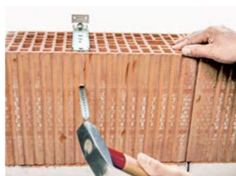
Lochschiene einschlagen
