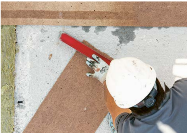
3. Porotherm-Pronouvo-Wandlager zuschneiden
