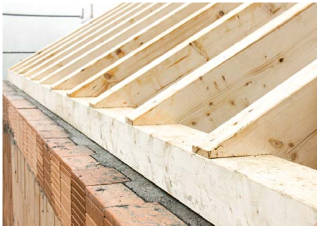
8. Ausbetonieren und z. B. Fusspfette befestigen
