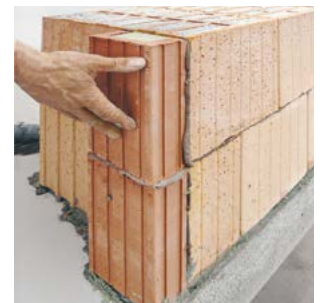
2. Einfach und sicher: Anschlagschale wird nachträglich mit Dünnbettmörtel seitlich an die Leibung geklebt
