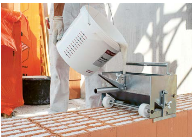
5. Mörtelschlitten füllen
